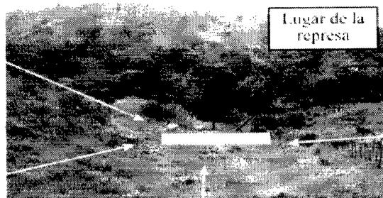
**Figura 5.** Depresión natural que podría servir como un reservorio Fuente: (CEMEDE, 2009). Una alternativa para aumentar la capacidad de almacenamiento sin incrementar la excavación, es usar la tierra removida para construir diques laterales, debidamente compactados, que permitan almacenar agua por encima del nivel natural del terreno.
