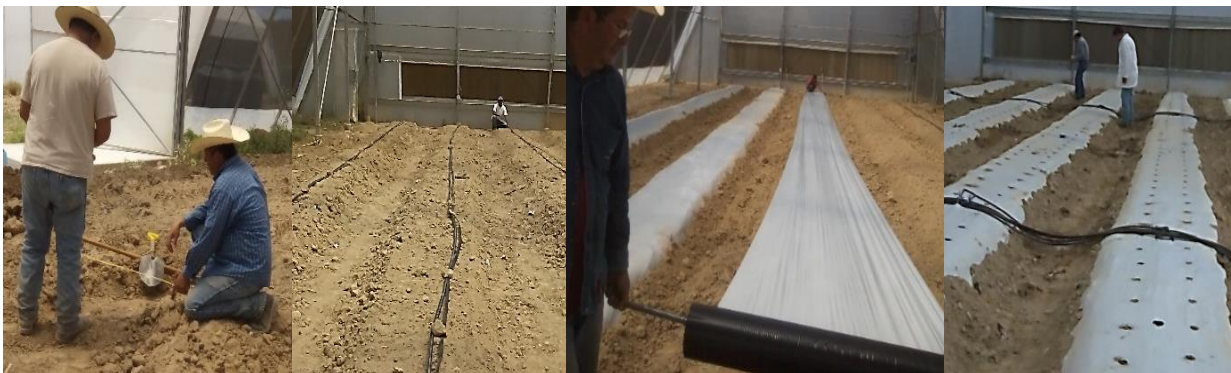
Figura 1. Preparación del terreno, elaboración de las camas, instalación de cintas de riego y acolchado plástico.
