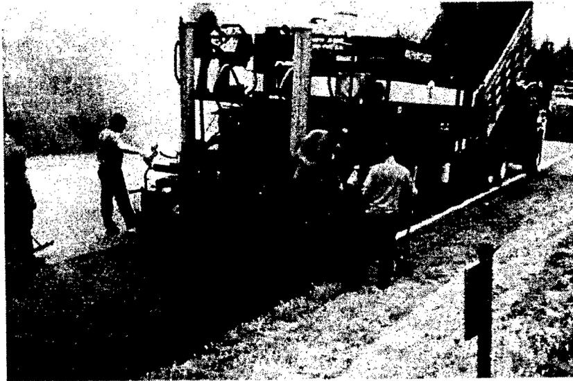
Fig. 13 Pavimentación con Hule Asfáltico
